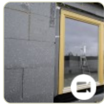
Ciepły montaż okien Sokółka w warstwie ocieplenia w systemie MOWO
